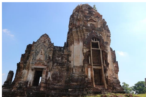
(ฉ) การเสริมคานและเสาคอนกรีตเสริมเหล็ก พระปรางค์วัดพระศรีรัตนมหาธาตุ
