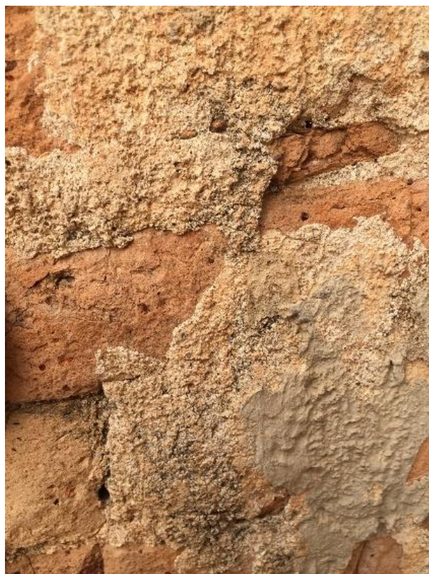
รูปที่ 2.23 ภาพขยายแสดงการหลุดร่อนและการกร่อนของวัสดุฉาบผิว ของอาคารประดิษฐานองค์พระวัดศรีชุม
