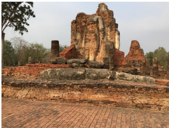
รูปที่ 2.26 อาคารส่วนหน้า (มณฑป) วัดพระพายหลวง พังทลายและพื้นไม่อยู่ในระนาบ
