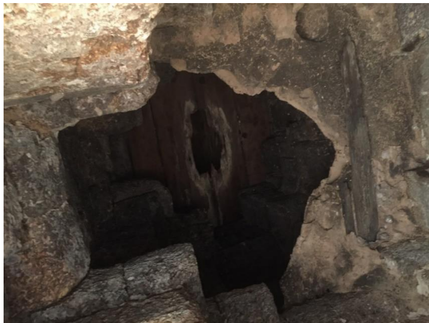
รูปที่ 2.17 เพดานพระปรารค์องค์กลางวัดศรีสวาย เป็นแผ่นไม้ มีช่องเปิด และมีสภาพผุบางส่วน
