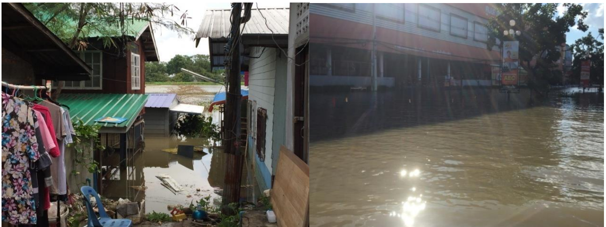
ภาพที่ 4.3 ความเสียหายที่เกิดขึ้นกับบ้านเรือนและสิ่งก่อสร้าง ที่มา: คณะผู้วิจัย (2562)
