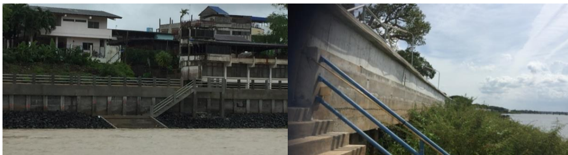
ภาพที่ 5.1 พนังกั้นน้ำริมแม่น้ำมูลฝั่งเทศบาลนครอุบลราชธานี และฝั่งเทศบาลเมืองวารินชำราบ
