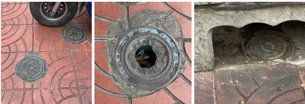
ภาพที่ 3-50 สภาพและตำแหน่งบางจุดของฝาท่อประปา
