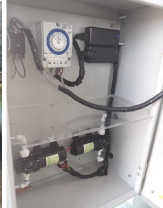
ภาพที่ 3 ลักษณะโครงเพาะเห็ด (ก) ระบบเปิดควบคุมการให้น้ำด้วยแรงงานท้องถิ่น และ (ข) ระบบปิดควบคุมการให้น้ำด้วยชุดควบคุมอัตโนมัติ
