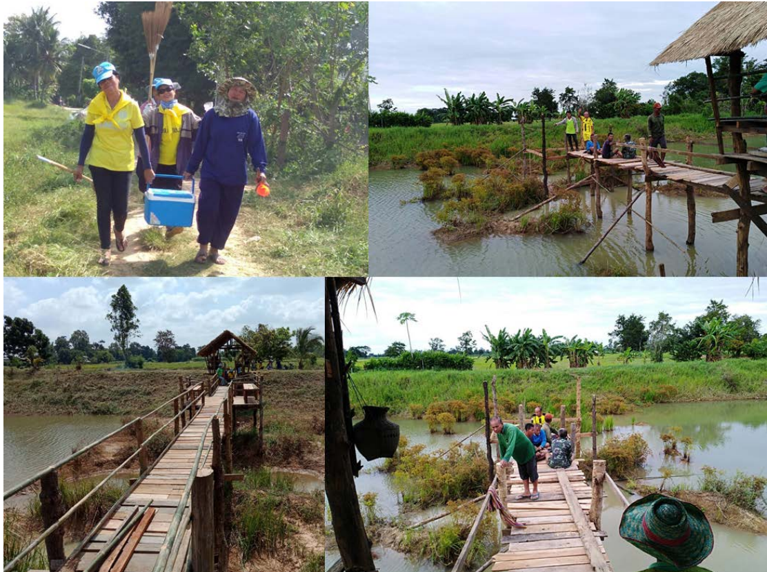
ภาพที่ 4.12 การก่อสร้างแต่งเติมสะพานบรรยากาศชมวิวลำห้วยหวาย
