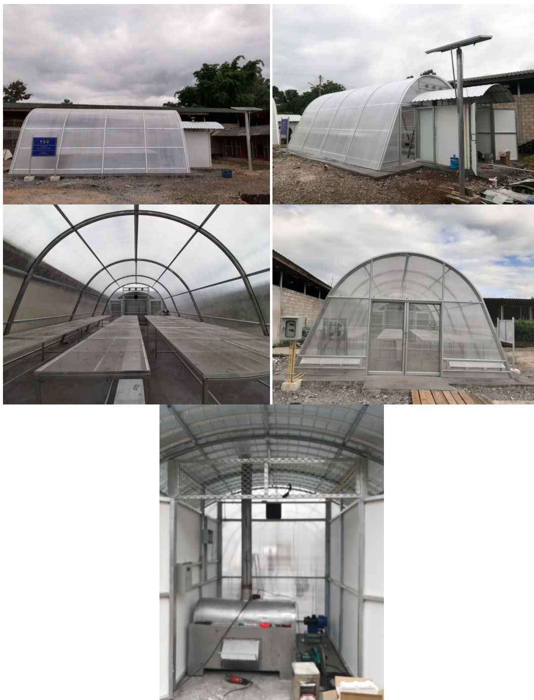
ภาพที่ ค.2 การพัฒนาเทคโนโลยีโรงอบแห้งถั่วแมคคาเดเมียแบบพลังงานร่วม (ชีวมวล-แสงอาทิตย์)
