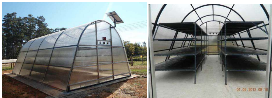
ภาพที่ 2.7 ระบบอบแห้งพลังงานแสงอาทิตย์แบบเรือนกระจก
