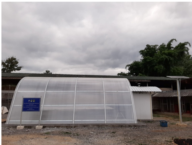
ภาพที่ 4.13 ผลการสร้างโรงอบแห้งถั่วแมคคาเดเมียแบบพลังงานร่วม (ชีวมวล-แสงอาทิตย์)
