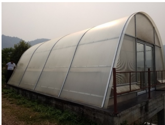
ภาพที่ 4.1 ลักษณะโรงอบแห้งแมคคาเดเมียของบ้านบ่อเหมืองน้อย
