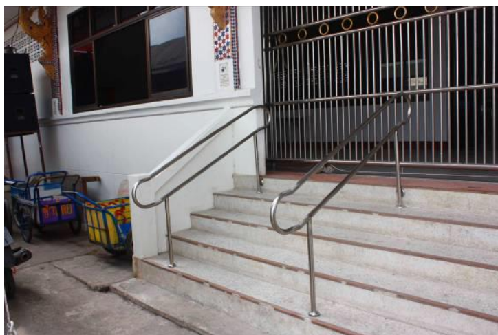
ภาพที่ 2-27 แสดงตัวอย่างบันไดทางเข้าอาคารสาธารณะ (ไตรรัตน์ จารุทัศน์, 2556, หน้า 5)
