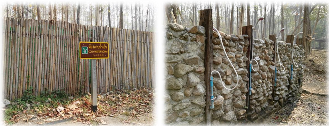
ภาพที่ 4.28 ห้องอาบน้ำเย็น โป่งน้ำร้อนท่าปาย
