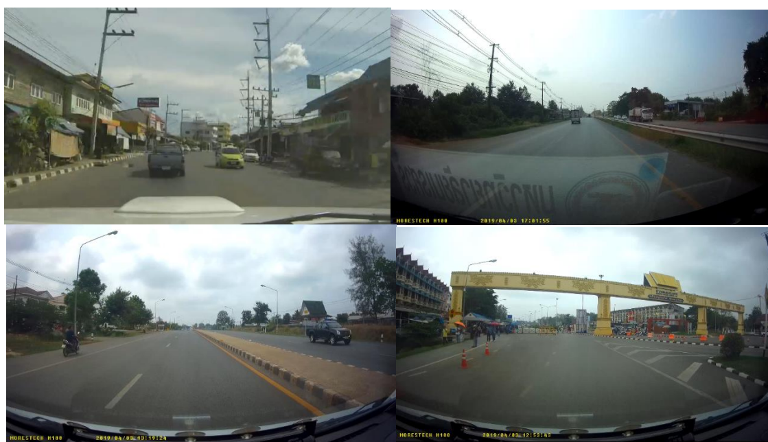
รูปที่ 4.28 สภาพเส้นทางช่วงด่านพุน้ำร้อน-ด่านหนองคาย ที่มา : ข้อมูลจากการลงพื้นที่
