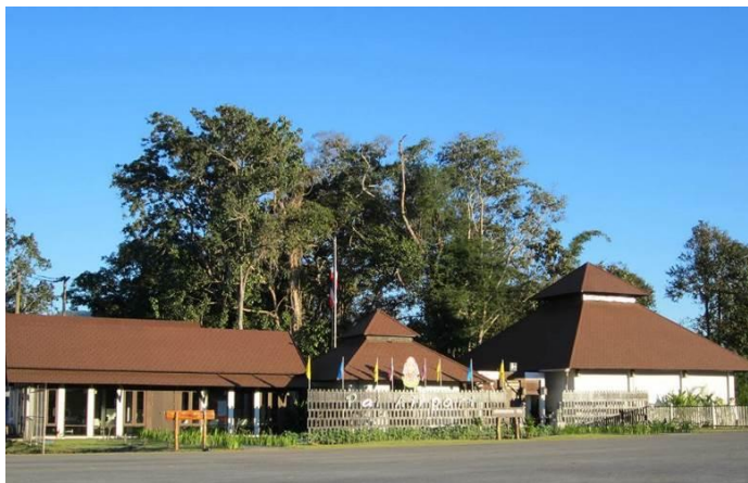
ภาพ 4-21 ท่าอากาศยานปาย ที่มา : ท่าอากาศยานปาย
