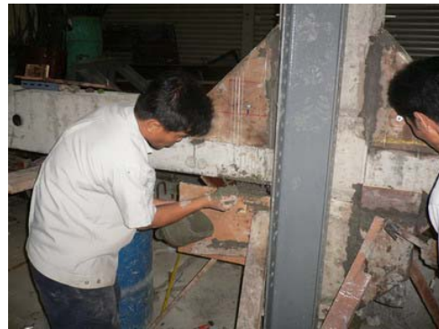
(ง) หล่อคอนกรีต
