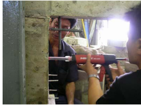
(ข) ฝังเหล็กยึดด้วยอีพ็อกซี่
