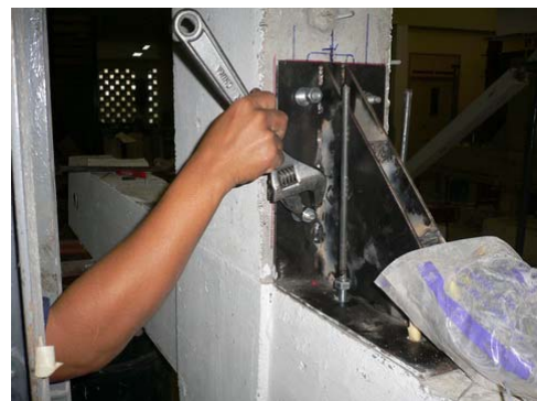
ง) ขันสลักเกลียวเพื่อยึดบ่าเหล็กกับจุดต่อ
