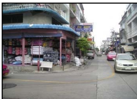
ถนนทางเข้าโรงเรียน
