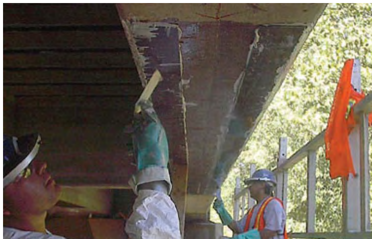
ภาพที่ 2.10 การเสริมความแข็งแรงโดยใช้ วัสดุ CFRP แบบกระดาะ (CFRP laminate) (Hughes Brothers, 2003)
