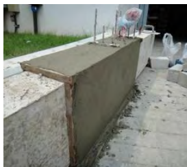
รูปที่ 11 การประยุกต์ใช้เฟอร์ไรซีเมนต์เสริมกำลังบริเวณทาบต่อเหล็กเสริม
