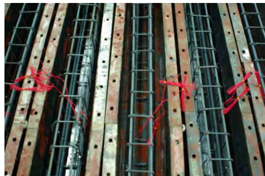
(ง) การติดตั้งโครงเหล็กในแบบหล่อ
