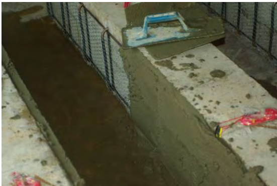
(จ) การฉาบมอร์ต้าลงบนเหล็กเสริม
