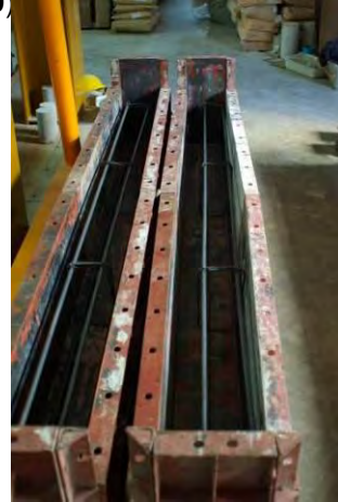
(ข) การเตรียมแบบหล่อคาน
