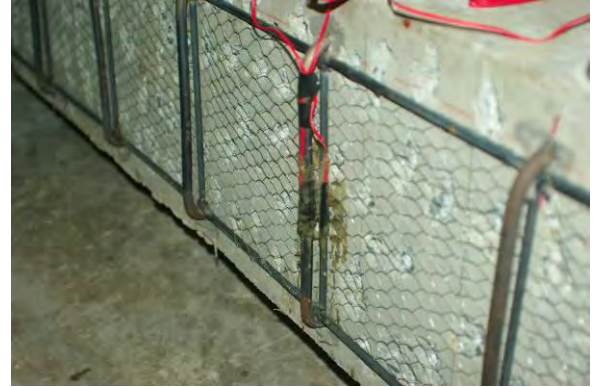
(ง) การติดตั้ง Strain gage ที่เหล็ก
