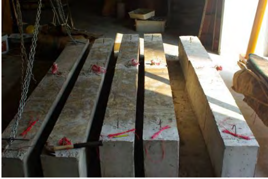
(ข) การถอดแบบหล่อคอนกรีต
