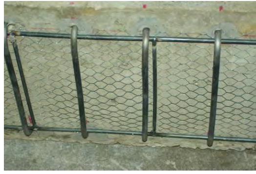
(ค) ทาบเหล็กโครงกับเหล็กเสริมรูปตัวซี
