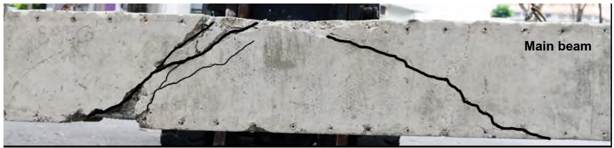
รูปที่ 4.21 รอยร้าวที่เกิดขึ้นในแผ่นเพอโรซีเมนต์ (บน) และในคาน (ล่าง)
