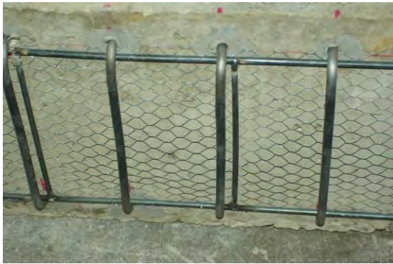
(ง) การติดตั้งเหล็กเสริมในคานโดยใช้ Epoxy เสริม
