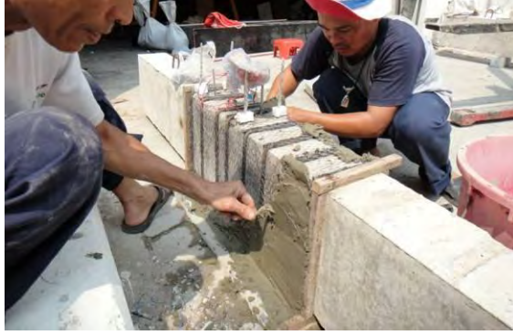
(ข) การฉาบผิวด้วยเฟอร์โรซีเมนต์
