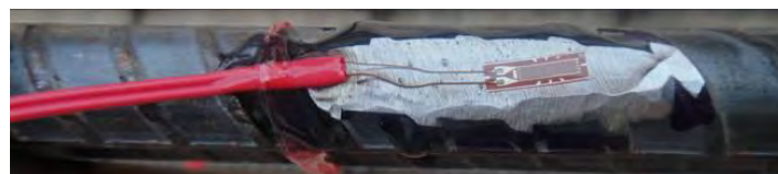
รูปที่ 5.8 การติดตั้ง Strain gages
