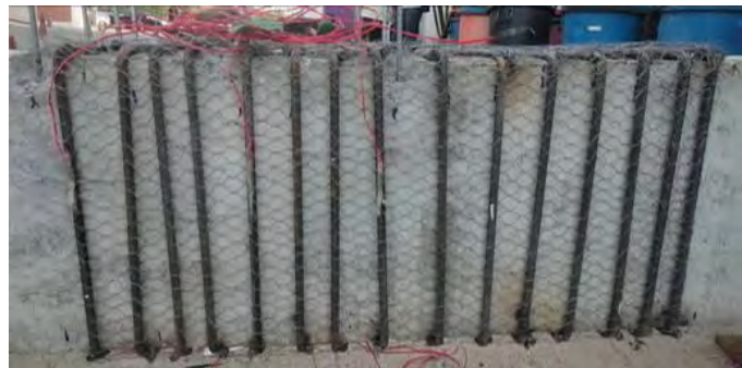
(ก) แนวการติดตั้งเหล็กโครง
