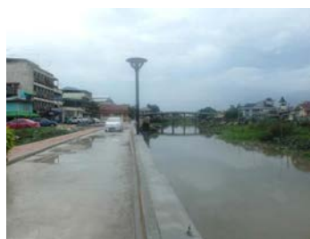
ภาพที่ 21-22 คันป้องกันน้ำ บริเวณแม่น้ำน้อย ของระบบป้องกันน้ำท่วมพื้นที่ชุมชนเสนา และสามกอก ที่มา: เสฏฐวุฒิ บำรุงกุล
