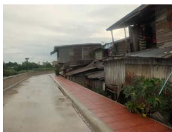
ภาพที่ 21-22 คันป้องกันน้ำ บริเวณแม่น้ำน้อย ของระบบป้องกันน้ำท่วมพื้นที่ชุมชนเสนา และสามกอก ที่มา: เสฏฐวุฒิ บำรุงกุล
