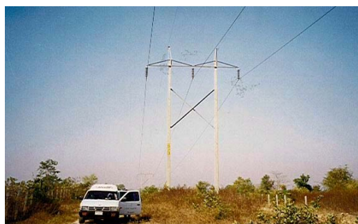
รูปที่ 3-26 สายส่ง 115 kV สายเดี่ยว วงจรเดี่ยว (LP1-MM2)
