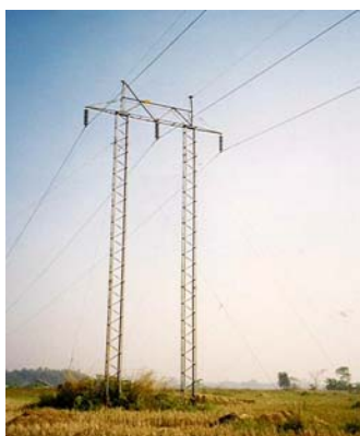
รูปที่ 3-25 สายส่ง 115 kV สายเดี่ยว วงจรเดี่ยว (LP1-TE)
