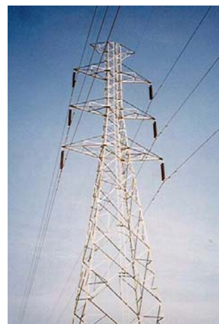
รูปที่ 3-24 สายส่ง 230 kV สายเดี่ยว วงจรคู่ (MM2-CR)
