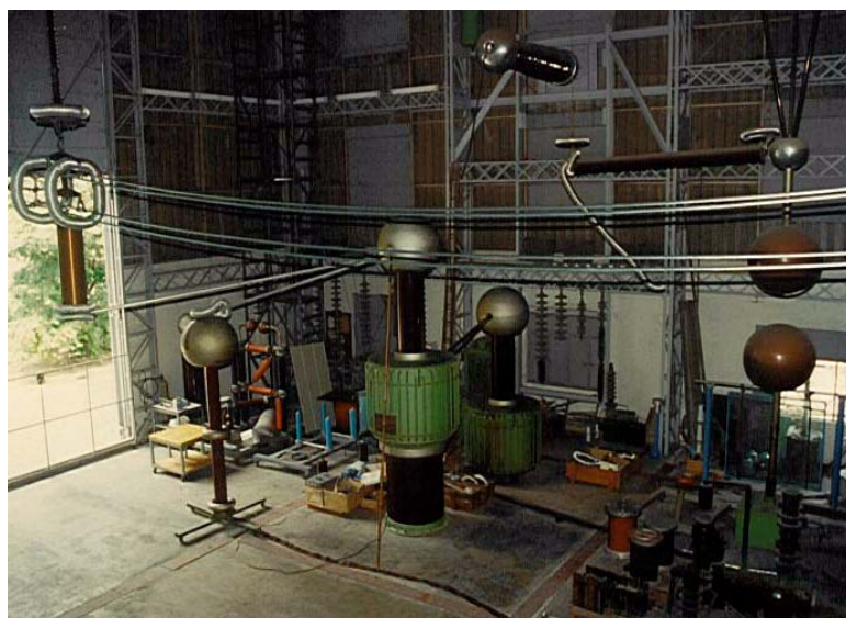
รูปที่ 3-5 การติดตั้งสายส่งในห้องปฏิบัติการ
