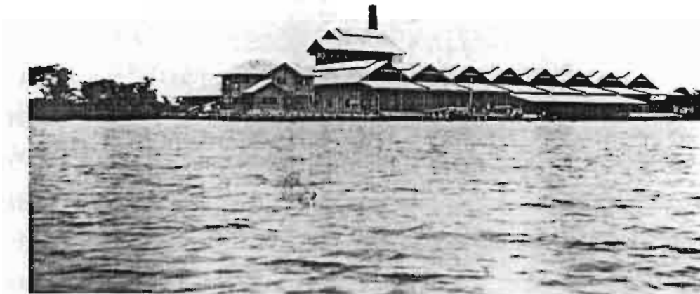
ภาพที่ 25 โรงสีบริษัทข้าวไทยปักษ์ใต้ จำกัด ตั้งอยู่บนฝั่งขวาของแม่น้ำปากพนัง ปัจจุบันเหลือแต่ปล่องโรงสีที่ก่อด้วยอิฐตั้งอยู่หลังโกดังงานโครงการพัฒนาลุ่มน้ำปากพนังเป็นโรงสีไฟที่ใหญ่ที่สุดในภาคใต้ เป็นภาพที่ถ่ายในราวปี พ.ศ.2491
