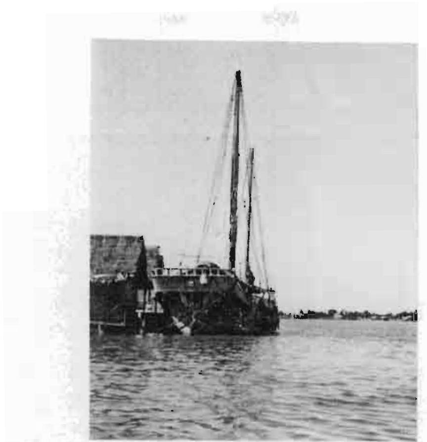
ภาพที่ 35 เรือลำนาสองหลัก เรือที่ชาวจีนไหหลำเป็นผู้ริเริ่มนำมาใช้ในลุ่มน้ำปากพองโดยต่อเนื่อง ในเมืองไทยสามารถบรรทุกข้าวได้ 100-200 กระสอบ นำแล่นไปถึงสิงคโปร์ เมื่อเข้าในแม่น้ำ ลำคลองไม่มีลมก็สามารถใช้พายหรือท่อนได้ ทำหน้าที่บรรทุกข้าวสารไปส่งปลายทางโดยตรง หรือรับจ้างลากจูงเรือปักจ่ายที่บรรทุกข้าวสารจากโรงสีไปขึ้นเรือยนต์เดินสมุทรขนาดใหญ่ ที่ทอดสมออยู่กลางทะเลใกล้ปากคลองพญาและปากคลองปากพูน
