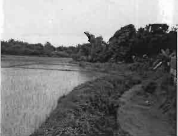
รูป 3.10 ลำเหมืองย่อยระบายส่งน้ำได้หลายระดับ
