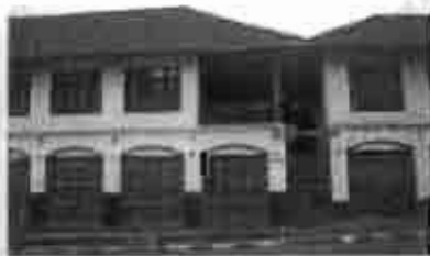
รูป 6.31 รูปแบบของอาคาร "ทรงคอก" และ หลังคา "ทรงปั้นหยา" ของกลุ่มเรือนร้านค้า ในตลาดเชียงตุง
