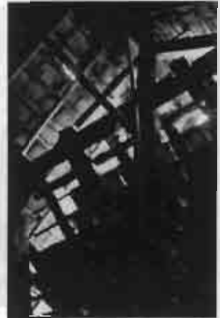
รูป 5.129 ส่วนของหน้าจั่ว ซึ่งเปิด โล่งสำหรับระบายอากาศ
