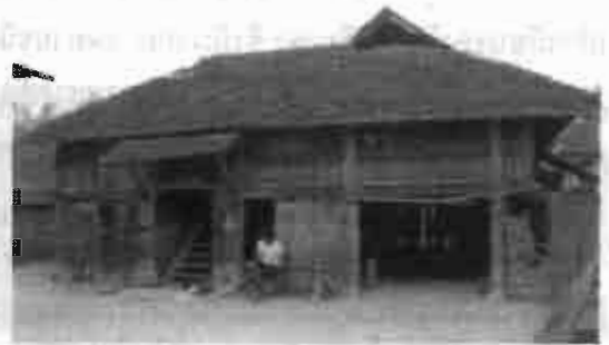
รูป 7.25 เรือนผนังไม้จริงผสมไม้ไผ่
