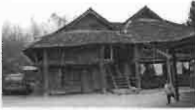
รูป 5.134 ลักษณะรูปทรงหลังคาแบบ "เรือนแฝด"
