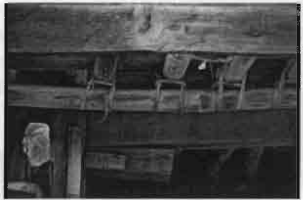
รูป 5.121 ลักษณะของโครงสร้างส่วนพื้นเรือน ซึ่งยังคงเป็นแบบผสมระหว่างระบบ "เครื่องผูก" กับ "ไม้จริง"
