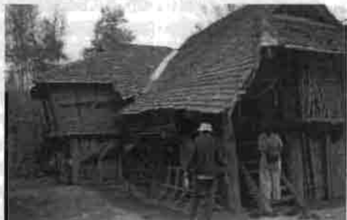
รูป 6.29 เรือนขยายของชาวไทเขินที่เชียงตุง มักทำเป็นแบบ “มุข” ชนด้านข้าง
