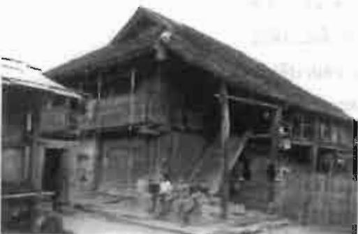
รูป 7.28 เรือนผนังไม้จริงผสมก่ออิฐ
