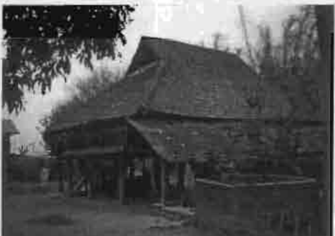
รูป 6.4 รูปแบบลักษณะหลังคาของ "ไทเขิน" ที่เชียงตุง กับการตั้งปึกหลังคา ด้านข้างเรือนเพื่อคลุมพื้นที่ด้านรับวาง "หลองข้าว"
