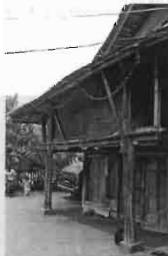
รูป 5.136 การใช้ค้ำยันช่วยยึดปีกชายคากับกันสาด
