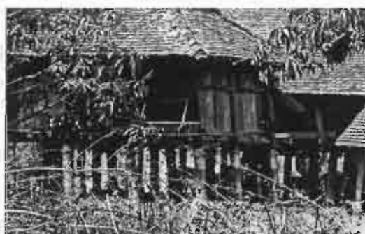
รูป 3.56 เยข้าวที่มีอุปกรณ์กันหนูกับปลวกที่เสาทุกต้น
