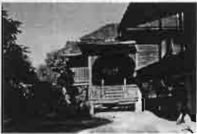
รูป 5.81 ลักษณะการตีระแนงไม้เป็นรูปโค้งเป็นแบบอย่างนอกพื้นที่ซึ่งแพร่เข้ามา
