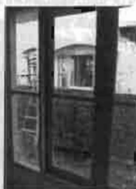
รูป 6.54 การทำช่องเปิดด้วยวัสดุอย่างใหม่
