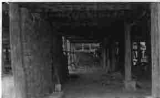
รูป 6.27 แนวของ “อิฐ” ที่วางซ้อนกันระหว่างช่องเสา บริเวณได้ทุนเรือน
