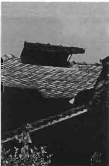
รูป 5.17 หลังคาจั่วขนาดเล็กที่ยกขึ้นเหนือครัวไฟเพื่อระบายอากาศ
