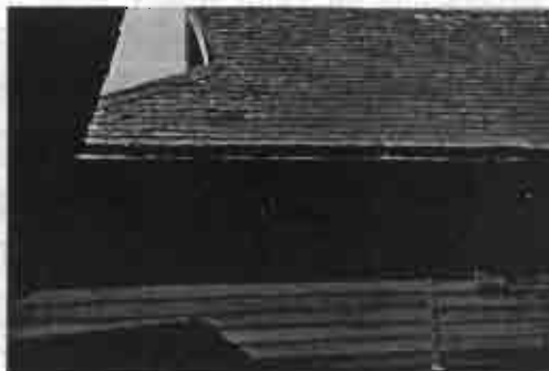
รูป 5.5 ลักษณะการใช้ไม้กระดานตีเป็นแผงฝายในแนวนอน
