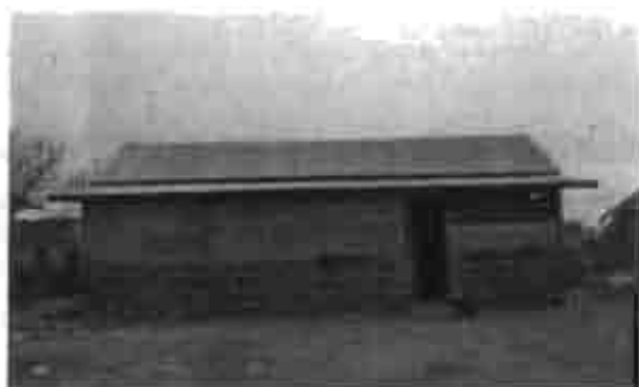
รูป 6.63 เช่นเดียวกับวัดมุงที่เปลี่ยนจาก “กระเบื้องดินเผา” มาเป็น “สังกะสี”
