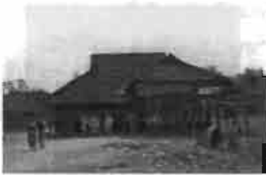
รูป 5.227, ลายเส้น 5.167 ลักษณะของเรือนที่นิยมใช้หลังคาแบบ "พับศอก"
