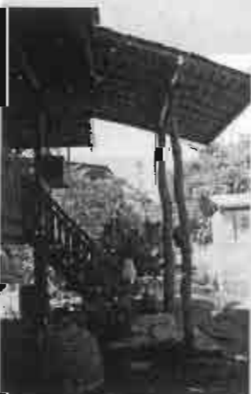
รูป 5.31 “เสาหลังหมา” กับปีกกันสาด
