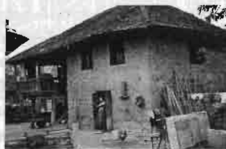
รูป 5.148 การปรับเปลี่ยนวัสดุก่อสร้าง จากผนังไม้เป็นผนังก่ออิฐ
