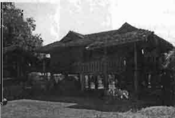
รูป 5.29 “ปีกนก” ที่ยื่นลงมาคลุม “บันได” ทางขึ้นเรือนด้านหน้า
