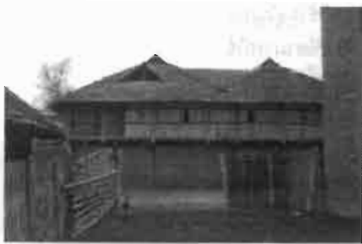
รูป 7.24 เรือนผนังไม้จริง
