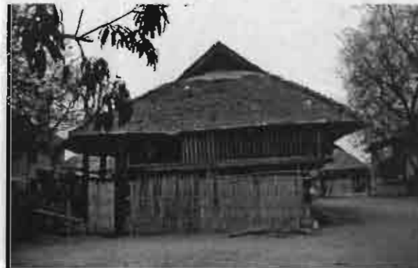
รูป 5.118 หลังคาเรือนแบบ "จั่วมะนิลา" หรือจั่วบ้านหยา ที่คลุมพื้นที่เรือน
