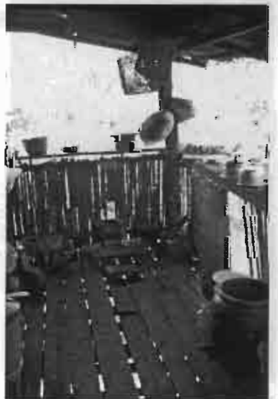
รูป 5.78 ลักษณะของ "ซานหลัง" ที่เปิดโล่ง และตีพื้นเว้นร่องสำหรับการซักล้าง
