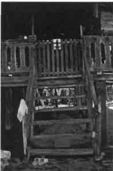
รูป 5.99 “บันได” ทางขึ้นเรือนแบบตั้งฉากกับชาน
