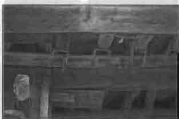
รูป 6.19 เช่นเดียวกับโครงสร้างของพื้นเรือน ซึ่งยังใช้ระบบเครื่องผูกประกอบกับไม้จริง
