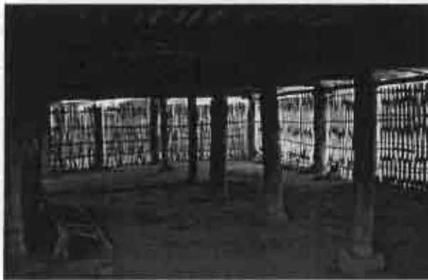
รูป 5.120 ส่วนของใต้ถุนเรือนกับการปิดล้อมด้วยฝาขัดแตะโปร่งๆ
