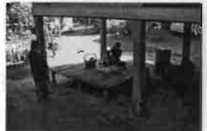
รูป 5.76 ช่วงห่างของเสาเรือน เทียบสัดส่วนกับคน
