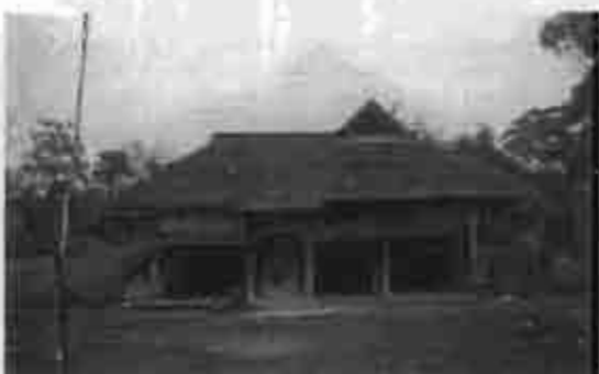
รูป 6.25 บางหลังก็ใช้วิธีการต่อขยายเรือนออกมาเป็นรูปวาง จากกัน
