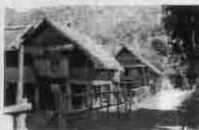
รูป 6.40 เรือนไม้จริง แต่ผสมกับโครงสร้างแบบเครื่องผูกโดยเฉพาะกับส่วนของหลังคาซึ่งต่อมาเรือนของเขียงใหม่ได้เปลี่ยนมาใช้มุงด้วยใบ “ตองดึง” แทน
