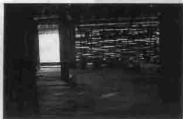
รูป 6.17 ภายในเรือนกับลักษณะของฝาขัดแตะ และที่ปูด้วยฟาก
