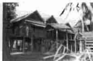
รูป 6.41 รูปลักษณะของเรือนที่เปลี่ยนมาเป็นระบบไม้จริงทั้งหมด โดยเฉพาะหลังคาที่มุงกระเบื้องแบบ “นบิ่นเกล็ด”
