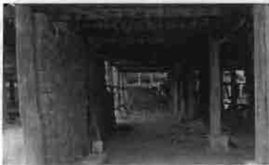
รูป 6.27 แนวของ “อิฐ” ที่วางซ้อนกันระหว่างช่องเสา บริเวณใต้ทุนเรือน
