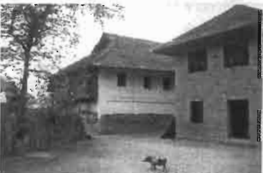
รูป 7.30 เรือนก่ออิฐและก่ออิฐฉาบปูน
