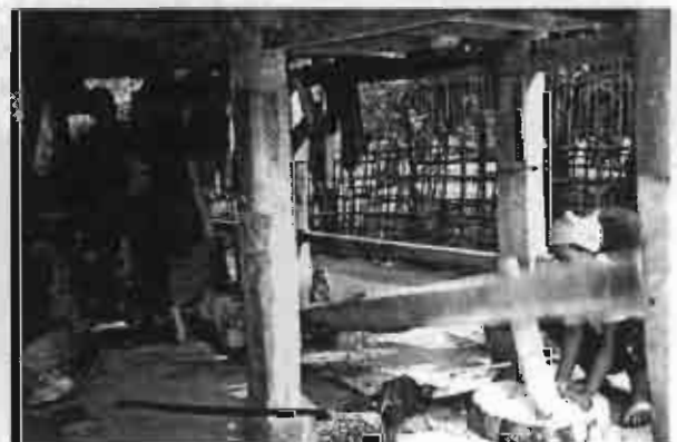
รูป 33 ครกกระเดื่องและหลุมที่ขุดให้ระยะของคานสูงจากดิน
