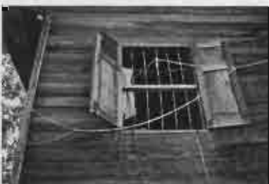
รูป 5.18 ลักษณะของ "ฝาเรือน" ที่ตีซ้อนกัน ในทางแนวนอน
