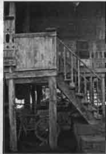
รูป 5.48 ลักษณะของราวบันไดและพนัก
