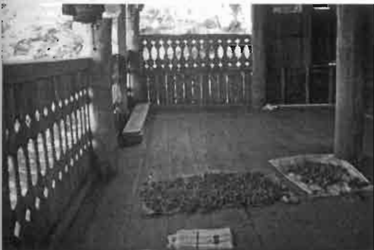
รูป 5.49 “เดิน” ส่วนหน้าเปิดโล่ง มีพนักเจาะเป็นช่องลมสลับลดหลาดยแบบเรขาคณิตที่น่าสนใจ
