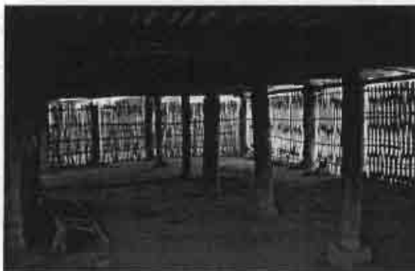
รูป 5.120 ส่วนของใต้ถุนเรือนกับการปิดล้อมด้วยฝาขัดแตะโปร่งๆ
