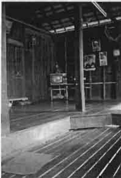
รูป 5.100 “เสามงคล” และ “เสานาง” อันเป็นเสาหลักของเรือน
