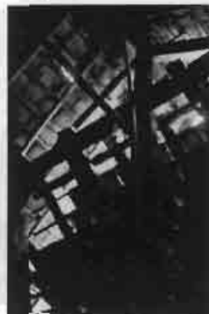
รูป 5.129 ส่วนของหน้าจั่ว ซึ่งเปิด โล่งสำหรับระบายอากาศ
