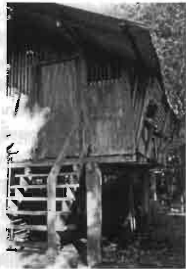
รูป 5.68 "บันได" ทางลงด้านหลัง
