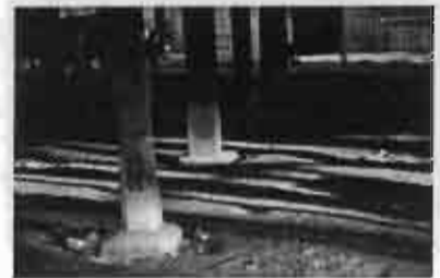
รูป 5.92 ลักษณะการวางเสาคาน "หิน" ตามลักษณะเดิมของ "เรือนไทเขิน"
