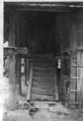
รูป 5.177 "บันได" ทางขึ้นเรือน ที่ซ่อนอยู่ได้ปกกันลาดด้านหน้า
