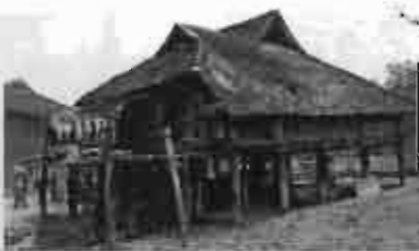
รูป 5.157 รูปทรงหลังคา ซึ่งมีลักษณะพิเศษตรงที่นิยมทำเป็นจั่วขนาดเล็ก
