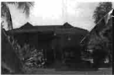
รูป 5.228, ลายเส้น 5.168 ลักษณะของเรือนที่นิยมใช้หลังคาแบบ "เรือนแผด"
