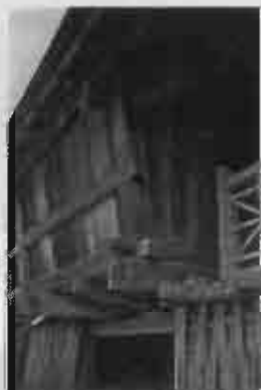
รูป 5.231 ฝาเรือนที่นิยมทำแบบ “ผายออก”
