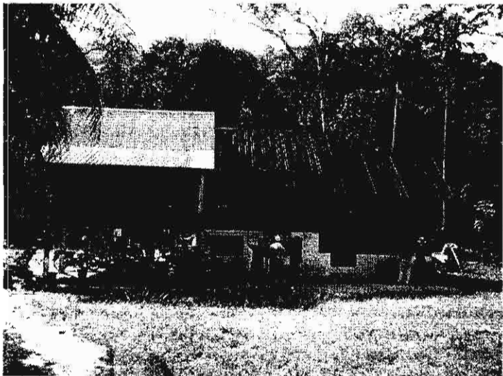
รูปที่ 3.78 การต่อเติมของเรือนซึ่งแสดงให้เห็นถึงรูปแบบของหลังคาปีกนกที่เอื้อต่อการ ต่อเติมได้ง่าย
