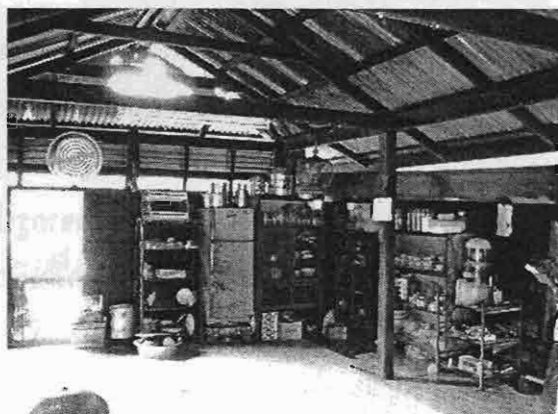
รูปที่ 3. 22 พื้นที่ส่วนเรือนครัวไม่มีการทำฝ้าเพดานมีการระบาย อากาศได้ดี
