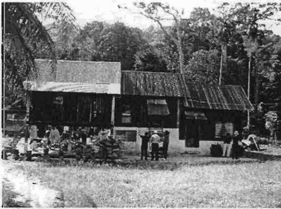
รูปที่ 3.67 ด้านข้างบ้านที่หันสู่ถนน
