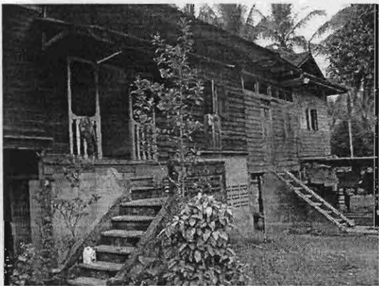
รูปที่ 4. 28 ลักษณะบ้านโค โครงสร้างไม้และก่ออิฐฉาบปูน
