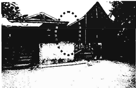
รูปที่ 8 ลักษณะการเชื่อมเรือนโดยการขึ้นชายคาคู่กัน
