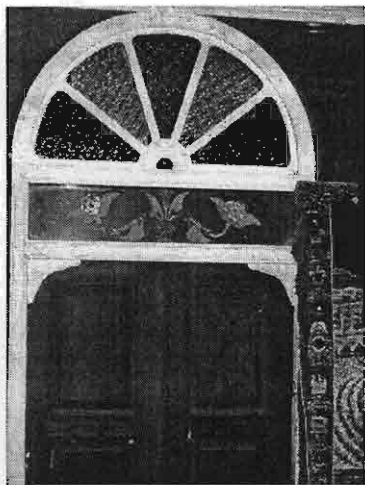
รูปที่ 3.35 การประดับช่องแสงเหนือประตู ด้วยกระจกลี และการเขียนลวดลายลงบน กระจก
