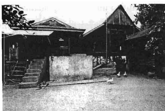
รูปที่ 3. 22 พื้นที่ส่วนเรือนครัวไม่มีการทำฝ้าเพดานมีการระบาย อากาศได้ดี
