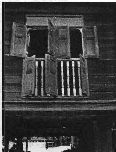
รูปที่ 3.37 ลักษณะช่วงเปิดบริเวณโรงภายใน เรือนมีการระบายอากาศได้ดี
