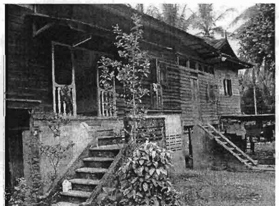
รูปที่ 3.34 ทางขึ้นด้านข้างเรือนและบันไดส่วน เรือนครัวมีการประดับประดาด้วยไม้คอง
