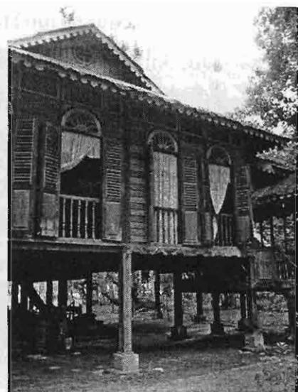
รูปที่ 3.91 แสดงช่วงเปิดบริเวณชานหน้าเรือนเห็น การเจาะช่องเปิดถึงพื้นเพื่อการระบายอากาศที่ดี
