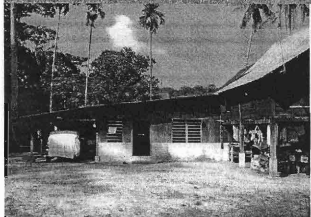
รูปที่ 4. 29 ลักษณะการต่อเติมของใต้ถุนเรือนที่พบเห็นโดยทั่วไป
