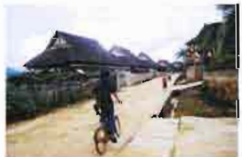
ภาพที่ 2-39 ถนนภายในหมู่บ้านห้วยแจ๋ เมืองหย่วน ที่มีการเตรียมระบบการระบายน้ำ
