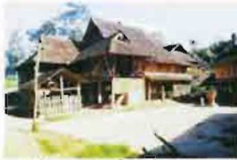
ภาพที่ 2-20 ลานโงบ้านคอนกรีตและเสาโงบ้านที่ทำจากอิฐและคอนกรีต ในหมู่บ้านไร่ไหม เมืองคาแควนสิบสองปันนา
