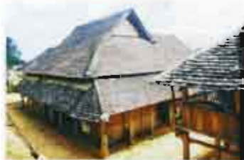
ภาพที่ 4-10 เรือนพื้นถิ่นไทลื้อในแคว้น สิบสองปันนา ที่มี "ปะ" วางทอดยาวจาก ฝาเรือนด้านหัวนอน (ทิศตะวันออก) สู่ฝา เรือนด้านทิศเหนือ (หมู่บ้านห้วยแจ เมือง หยวน แคว้นสิบสองปันนา)
