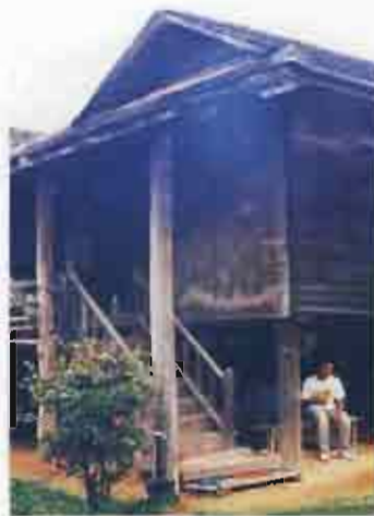
ภาพที่ 4-47 เสาทองหมารับหลังคาฟ้าใส
