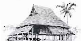
ภาพที่ 4-1 เรือนไทลื้อเป็นเรือนยกใต้ถุน หลังคาทรงจั่วผสมบันหย่า ขอบคาลาดต่ำ คล้ายกับลักษณะพวกหงส์ที่กางปีกและหางออก (ที่มา: อุเหลียงเหวิน, 2537 : 79,91)
