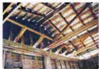
ภาพที่ 4-45 โครงสร้างหลังคา
