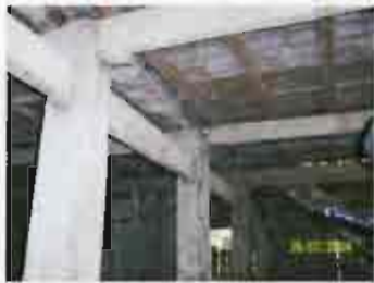
ภาพที่ 4-22 คาน 2 ระดับติดกัน
