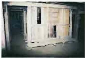
ภาพที่ 4-110 ห้องเก็บข้าวบริเวณใต้ถุน มีช่องเปิดให้ข้าวออกมา แบบแผ่นไม้ วางแนวนอนเรียงต่อกันทางสั้น (หมู่บ้าน ใน เมืองลา แคว้นสิบสองปันนา)
