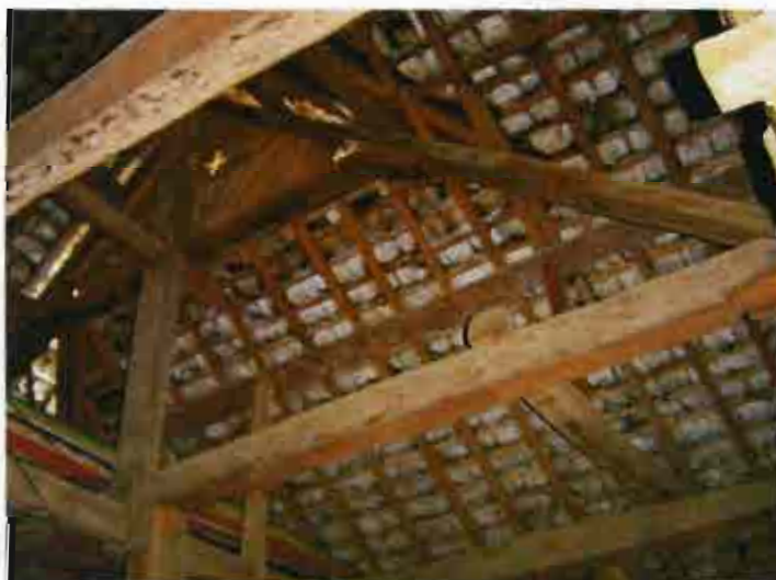
ภาพที่ 4-31 โครงสร้างหลังคา
