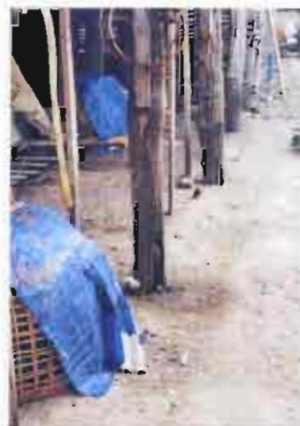
ภาพที่ 4-35 การวางเสาฐานเรือน
