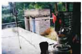
ภาพที่ 4-87 ล้วมในเขตรั้วบ้าน มองผ่านชานแดดที่ถูกดัดแปลงเป็นพื้นและโครงสร้างคอนกรีตเสริมเหล็ก (หมู่บ้านปางสาน เมืองบาง แคว้นสิบสองปันนา)
