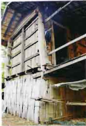
แบบฝาไม้ฉีก หมู่บ้านเชียงบาน
