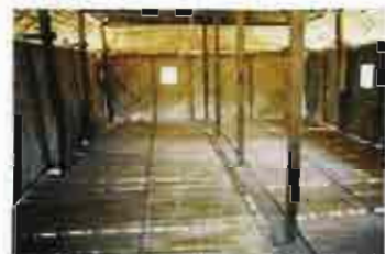
ภาพที่ 4-95 ภายในห้องนอนเรือนพื้นถิ่นไทลื้อ อ.เชียงคำ ถูกแบ่งด้วยแนวตงบังเป็น 2 ฝ่าย โดยฝั่งขวาจะไซเป็นส่วนนอน ฝั่งซ้ายไซเป็นที่พักนอนรับแขก หรือครัวไฟ (กรณีที่เป็นเรือนเดี่ยว) (เรือนไทลื้อตัวอย่าง หมู่บ้านธาตุ อ.เชียงคำ)
