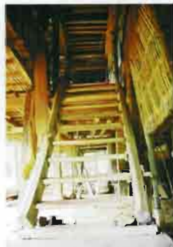
ภาพที่ 4-61 บ้านไต้เรือนพื้นถิ่นไทลื้อ ใน แคว้นสิบสองปันนา มีประตูแอ่วทำด้วย ไม้ไผ่สาน บ้านไต้จะวางชิดด้านในของ ระเบียงหน้าเสมีชนซ้อนกันด้านในไต้ถุน เรือน (หมู่บ้านสะก่า เมืองพง แคว้นสิบ สองปันนา)
