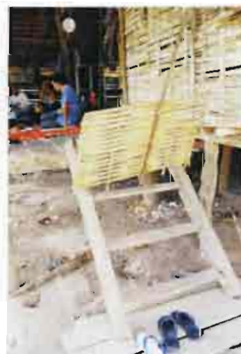
ภาพที่ 4-53 บันไดขึ้นเรือนเดี่ยว ขนาดเล็กได้ถูกเพิ่ม มีลักษณะประตู หน้าต่างแบบต่าง ๆ วัสดุบ้านใช้ไม้ ระเบียงค้ำ
