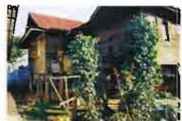
ภาพที่ 4-15 การเปลี่ยนแปลงของเรือนไทยลื้อที่ อ. เชียงคำ คือ หลังคามุงสังกะสี ฝาไม้ตั้งตรง ฝาซ้อนเกล็ดทางนอน มีการเจาะช่องหน้าต่างเพิ่มขึ้น
