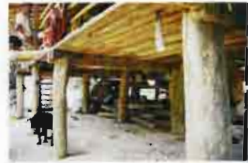
ภาพที่ 4-53 เรือนขนาดเล็กจะมีไตถุนเตี้ย ใช้เก็บของ เก็บฟืน เลี้ยงสัตว์ (หมู่บ้านทุ่งมอก อ.เชียงคำ จ.พะเยา)
