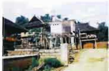
ภาพที่ 4-86 การต่อเติมห้องอาบน้ำ โครงสร้างคอนกรีตบริเวณชานนอก บนหลังคาห้องอาบน้ำใช้วางถังเก็บน้ำ และแผงเซลล์ไฟฟ้าแสงอาทิตย์ (หมู่บ้านห้วยแจ เมืองหยวน แคว้นสิบสองปันนา)
