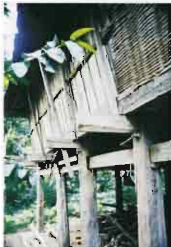
ภาพที่ 4-11 ฝาไม้จริงติดผนังโดยรอบ ออก จะช่วยลดความร้อนจากผนังที่สาดมา โดยไม่ปะทะลมที่พัดมา (หมู่บ้านสะก้า เมือง หยวน แคว้นสิบสองปันนา)
