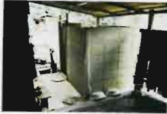
ภาพที่ 4-125 การต่อเติมห้องน้ำ-ส่วนบริเวณเขานวม (หมู่บ้านน้ำแวน อ.เชียงคำ)
