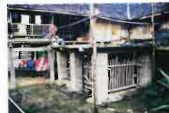
ภาพที่ 4-132 การเปลี่ยนชานนอกมาใช้โครงสร้างคอนกรีตเสริมเหล็ก (หมู่บ้านปางสำน เมืองมาง แคว้นสิบสองปันนา)
