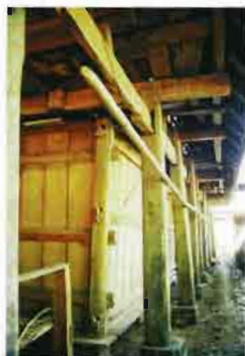
ภาพที่ 4-153 ผนังห้องเก็บข้าวทำด้วย ฝาไม้จริง ติดมาตั้ง มีโครงเคร่ารับผนังอยู่ด้านนอก (หมู่บ้านห้วยล่อ แคว้นสิบสองปันนา)
