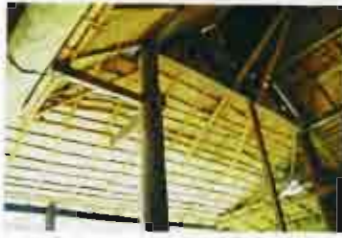
ภาพที่ 4-149 เสาคานเป็นไม้จริง โครงหลังคาเป็นไม้จริงผสมไม้ไผ่ (หมู่บ้านธาตุ อ.เชียงคำ)
