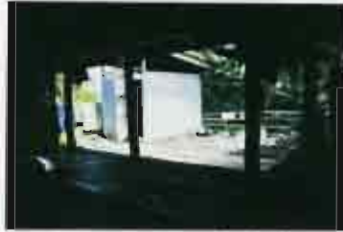
ภาพที่ 4-126 การต่อเติมห้องน้ำ-ส่วนบริเวณเขานวม (หมู่บ้านชาตุ อ.เชียงคำ)
