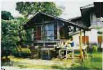
ภาพที่ 4-127 การเปลี่ยนหลังคาและฝ้ามุงข้าวเป็นสังกะสี (หมู่บ้านทุ่งมอก อ.เชียงคำ)
