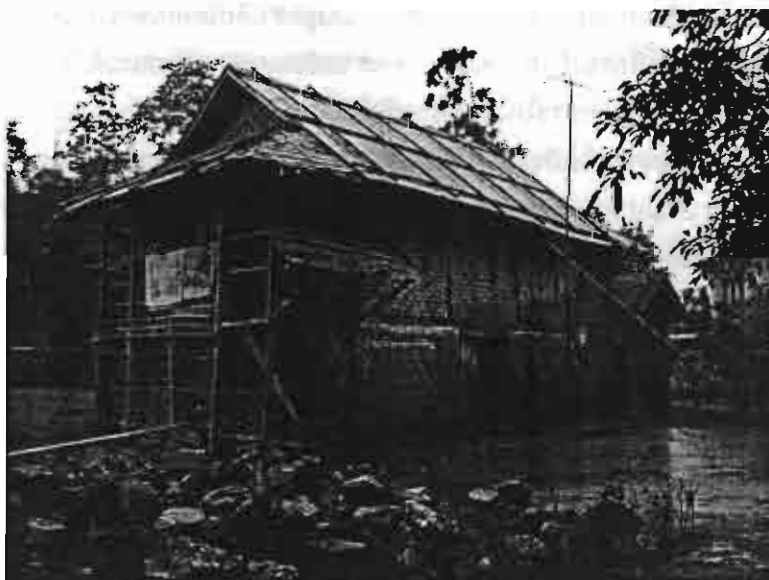
ภาพที่ 5.10 แสดงเรือนพื้นถิ่นที่มีการต่อเติมเพิ่มในส่วนใต้ถุนของชุมชนไทใหญ่ในแคว้นไตคง
