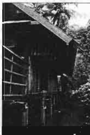
ภาพที่ 3.92 แสดงหิ้งวางของ (แข่ง) ที่ยื่นออกจากผนังเรือน หมู่บ้านดอแพ
