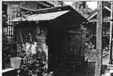
ภาพที่ 3.54 แสดงห้องน้ำที่ก่อสร้างด้วยผนึ่งคอนกรีต และหลังคาสังกะสี หมู่บ้านเมืองปอน
