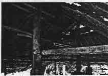
ภาพที่ 3.23 แสดงโครงสร้างหลังคาของ เรือนที่ใช้ไม้ไผ่และไม้จริง หมู่บ้านปางหมู
