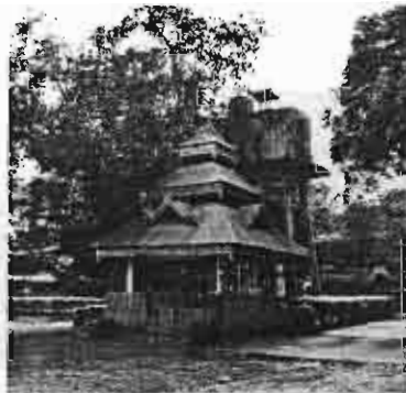
ภาพที่ 3.56 แสดงศาลาคลุมบ่อน้ำ วัดเมืองปอน
