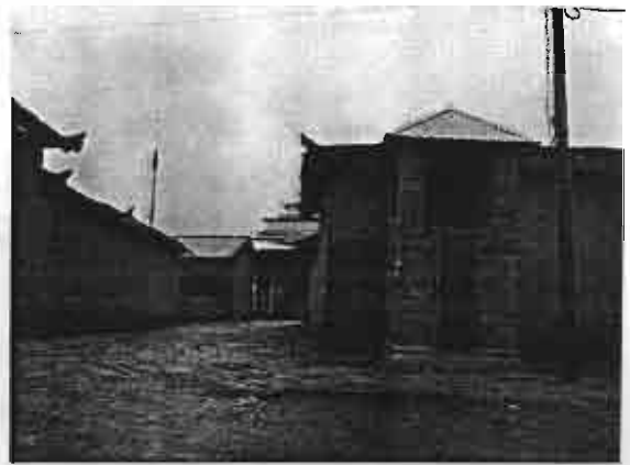
ภาพที่ 4.11 แสดงลักษณะศาลรูปเคารพที่ใช้งานคล้ายคลึงกับศาลเจ้าเมืองแบบดั้งเดิมในชุมชนไทใหญ่ หมู่บ้านน้ำสีซุน
