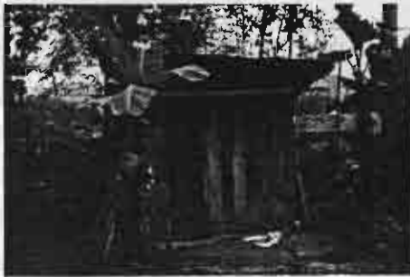
ภาพที่ 3.53 แสดงห้องน้ำที่ก่อสร้างด้วยผนึ่งไม้ และหลังคาสังกะสี หมู่บ้านเมืองปอน
