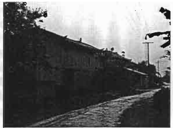
ภาพที่ 4.5 แสดงภูมิทัศน์บริเวณถนนย่อยภายในหมู่บ้านน้ำสีซุน
