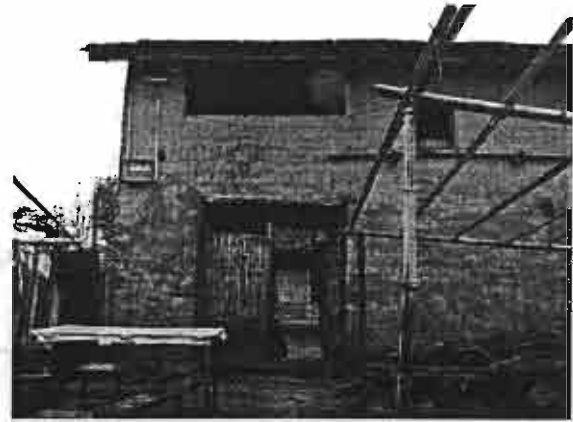
ภาพที่ 4.9 แสดงบริเวณทางเข้าเรือนพักอาศัยหมู่บ้านน้ำสี่ซุน
