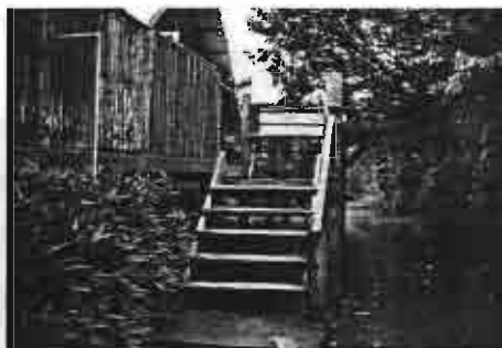
ภาพที่ 3.90 แสดงบันไดทางขึ้นบ้านติดกับชาน หมู่บ้านต่อแพ
