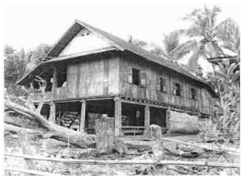
ภาพที่ 6-22 เรือนเลขที่ 83 หน่วย 06 บ้านเมืองชาย เปิดช่องหน้าต่างทุกช่วงเสา เพื่อการระบายอากาศภายในเรือน
