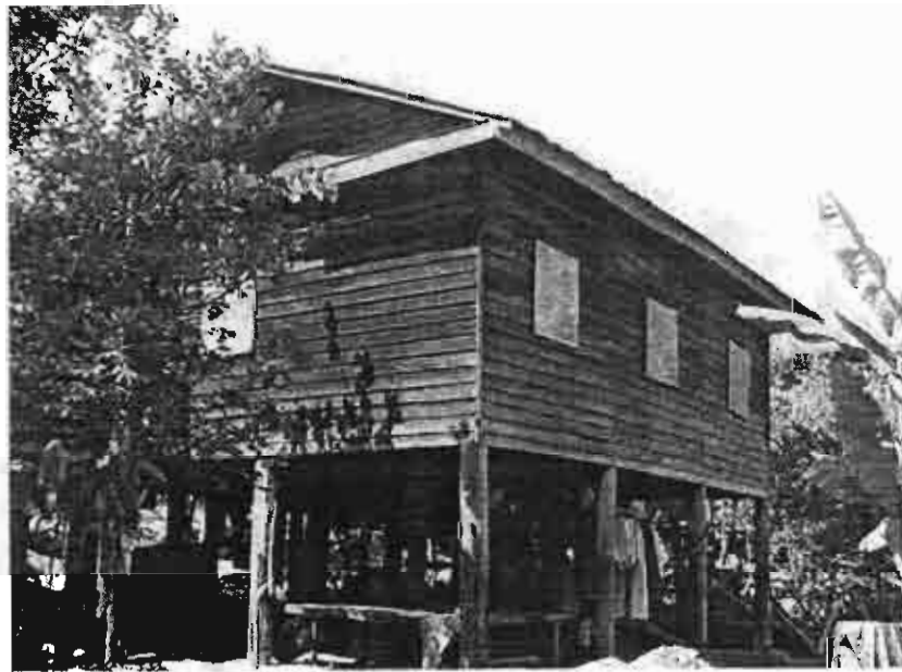
ภาพที่ 4-28 การเปิดช่องหน้าต่างตามแนวยาวของเรือนระยะหลัง
