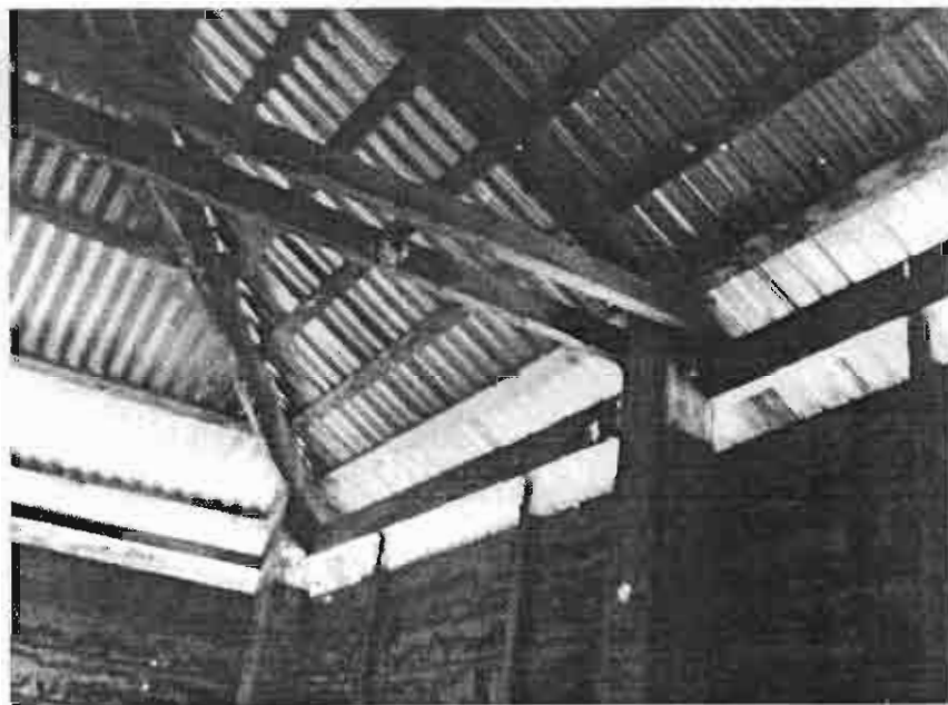
ภาพที่ 4-25 ที่ว่างระหว่างผนังและอะเสเพื่อการระบายอากาศภายในเรือนมุงหลังคาสังกะสี
