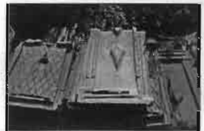
รูป 9.4 กระเบื้องดินเผาที่นิยมใช้มุงเรือนไทดำในละแวกเมืองเซินลาและเดียนเบียน
