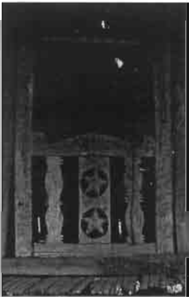
รูป 9.20 ลูกกรงกันตงของหน้าต่างเปิดติดพื้น ประดิษฐ์ลวดลายอย่างง่าย ๆ
