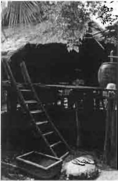
รูป 5.24 ชั้นโลขึ้นเรือนไทดำที่บ้านกวยมีการ แต่งแม่ชั้นโลให้โค้งแอ่นเล็กน้อย
