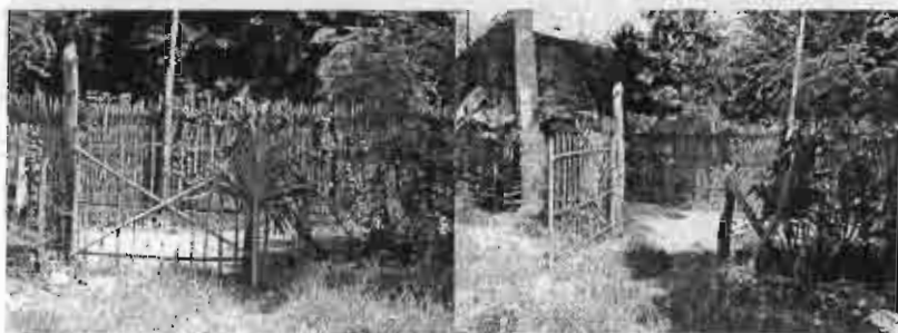
รูป 4.19 แสดงภาพประตูรั้วที่ปิดและเปิดโดยมีทางตาลเป็นตัวถ่วงน้ำหนัก
