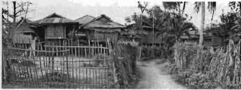
รูป 4.20 ภาพแสดงองค์ประกอบในอาณาเขตเรือนไทดำหลังหนึ่งตั้งอยู่ในบ้านหนองเข้
