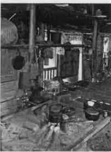
รูป 6.10 ก้อนเส้าและกะบะแม่เตาไฟภายใน เรือนไทดำในเวียดนาม
