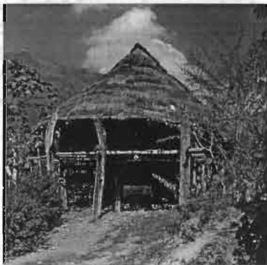
รูป 9.1 เรือนไทดำมีลักษณะทั่วไปเป็นเรือนเสาสูง หลังคาชัน มีชานเปิด
