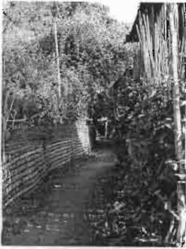
รูป 81.4 รั้วไม้ไผ่รวมไม้ไผ่ล้อมแซมกันทางเดิน ระหว่างเรือน
