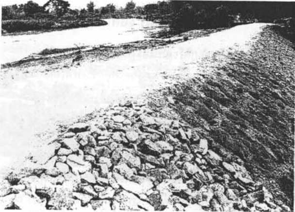
คันดินกันแม่น้ำดิน แนวทางการแก้ปัญหาน้ำท่วมของรัฐบาล เป็นคันดินอัดแน่นที่มีความยาว 1,871 เมตร สูง 4-5 เมตร จากหัวบ้านถึงท้ายบ้านหลวงเมืองดิน
