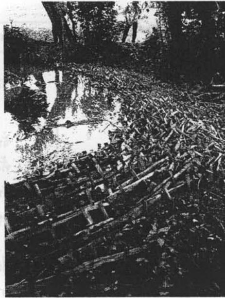
ฝายแม่หลวงทา อ.ลี ฝายไม้ที่สร้างเป็นรูปโค้ง เขาควาย ในลำห้วยแม่แต๊ะ
