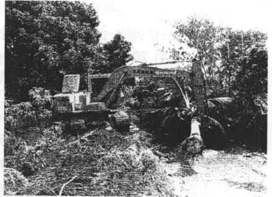
ในสังคมสมัยใหม่ ชาวนาไม่สามารถใช้เวลามาทำงานในระบบเหมืองฝายหลายๆ วันได้เหมือนในอดีต หลายๆ ฝายจึงแก้ปัญหาโดยการจ้างรถแบคโฮมาตีฝายล่องเหมืองแทนแรงงานคน
