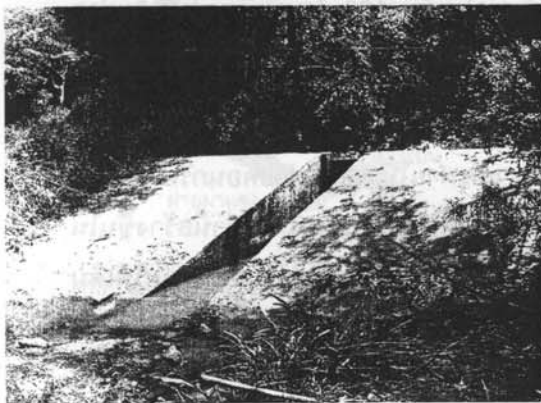
ฝายนาตุ้ม อ.ลี ฝายขนาดกลางในลำห้วยแม่แต๊ะ สร้างด้วย คอนกรีต มีประตูระบายน้ำตรงกลาง ช่วยให้ระบายได้ดี
