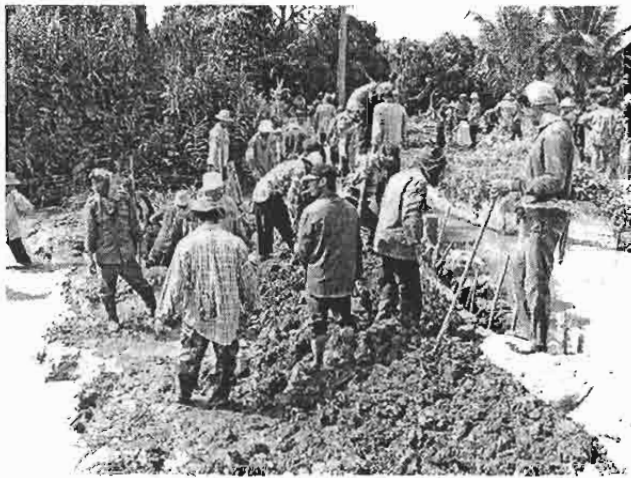
ซ่อมลำเหมือง ฝายเหมืองหลวง อำเภอฮอด จังหวัดเชียงใหม่
