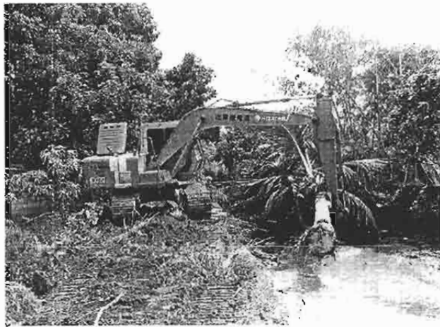
ฝ่ายเหมืองหลวงเมืองฮอด เลือกที่จะให้รถขุดเป็นเครื่องมือช่วยในการล้อมเหมือง เมื่อเกิดปัญหาลำเหมืองขาด แทนการใช้แรงงานคน เพราะต้องใช้แรงงานมาก งบประมาณในการจ้างรถขุดมาจากการเก็บ "ค่าน้ำ" จากลูกเหมือง ที่เก็บรวมไว้ตลอดทั้งปี
