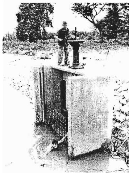
“ปากเหมือง” หรือประตูทางเข้าของลำเหมืองหลวง ตั้งอยู่ ณ ตำแหน่งที่ได้รับ การคำนวณแล้วว่าจะมีน้ำไหลเข้าลำเหมืองได้อย่างเพียงพอ
