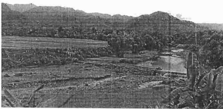
ฝายขนาดเล็กสร้างด้วยหินซ้อนทับเป็นชั้น พบที่หมู่บ้านไทดำ ทางตอนเหนือของประเทศเวียดนาม
