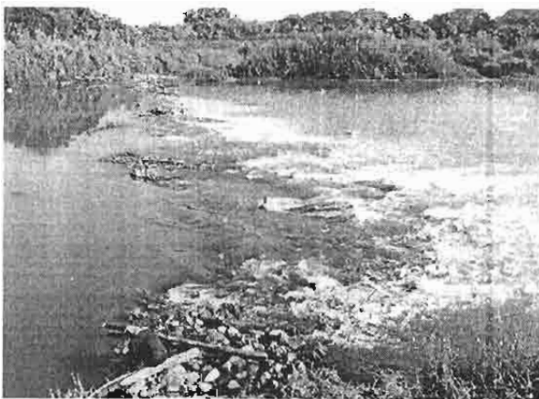
ฝายสบล้อง ฝายหินทิ้งที่ทดน้ำจากลำน้ำปิง ในเขต อำเภอหางดง จังหวัดเชียงใหม่
