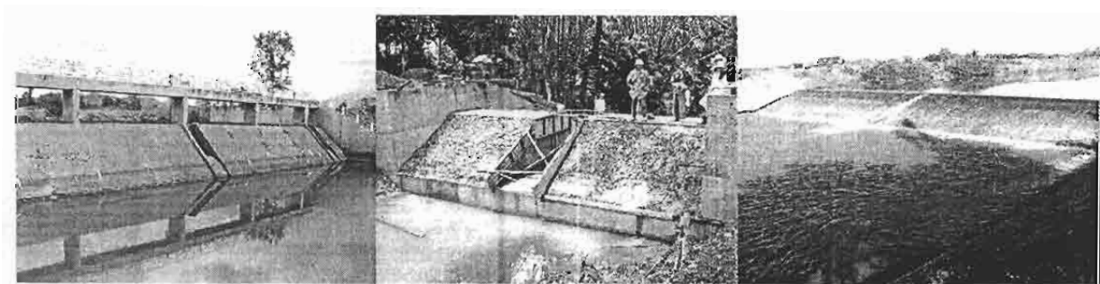
ฝายคอนกรีตที่พบได้ทั่วไปในพื้นที่แอ่งเชียงใหม่ - ลำพูน
