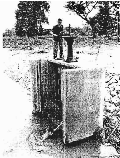
ประตูเหมืองหลวง “ฝ่ายเหมืองหลวง” ประตูน้ำที่ได้รับการปรับปรุงใหม่ประตูเปิดเพื่อให้สะดวกในการควบคุมปริมาณน้ำที่ไหลเข้าสู่ลำเหมือง
