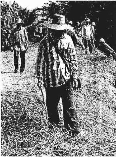
การใช้ "ไม้จอก" วัดเพื่อแบ่งพื้นที่การทำงานเหมืองฝ่ายของลูกเหมือง
