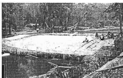
ฝายหัวเมือง ฝายไม้ที่ทดน้ำจากน้ำแม่แดง อำเภอเชียงดาว จังหวัดเชียงใหม่
