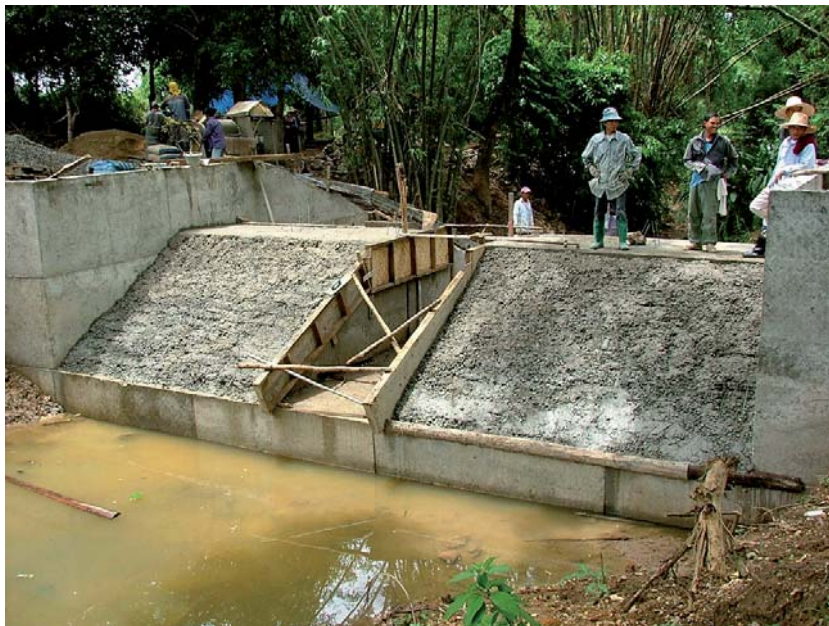
ฝายคอนกรีต
