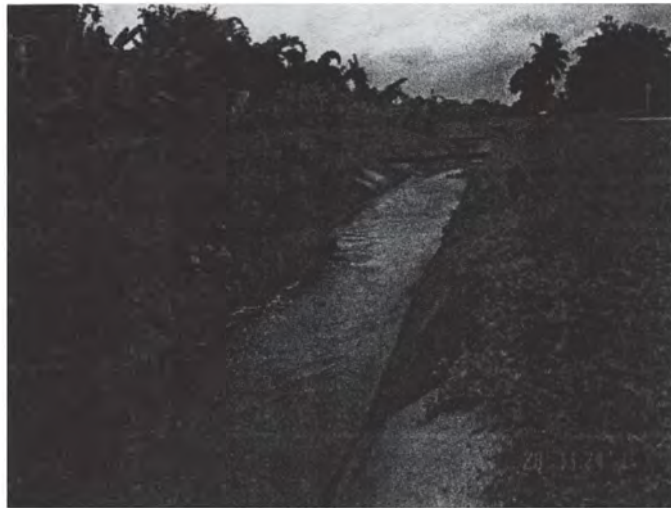
คลองส่งน้ำชลประทานแม่งัดบริเวณ บ้านเด่น ต.อินทนิล อ.แม่อาย
