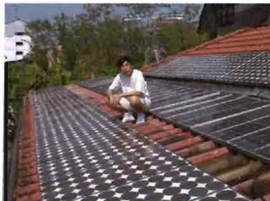
การใช้ระบบเซลล์แสงอาทิตย์ กับบ้านที่อยู่อาศัยในเมือง
