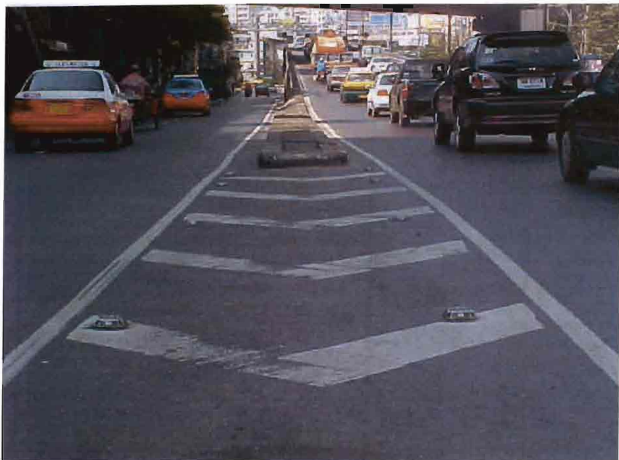
การใช้กับไฟกระพริบที่ติดตั้งตามทางแยกในกทม
