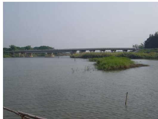
บ้านท่าดินดำเดือนพฤศจิกายน 2546
