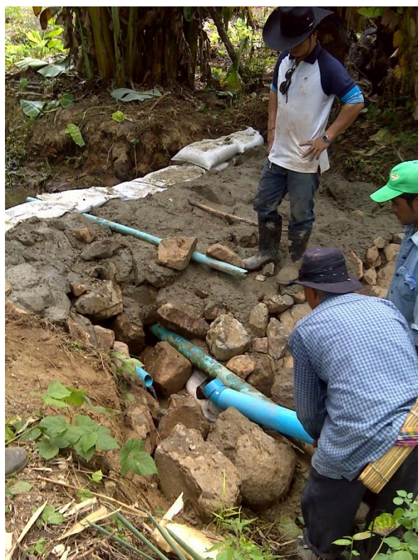
ภาพที่ 4.50 การวางท่อเพื่อนำน้ำจากฝายชะลอน้ำไปใช้ในแปลงเกษตร
