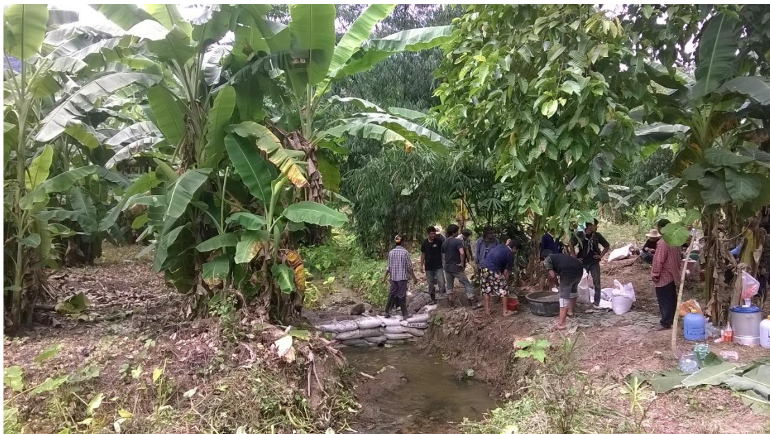
ภาพที่ 4.49 การสร้างฝายชะลอน้ำพื้นที่ต้นน้ำขุนผาใหญ่
