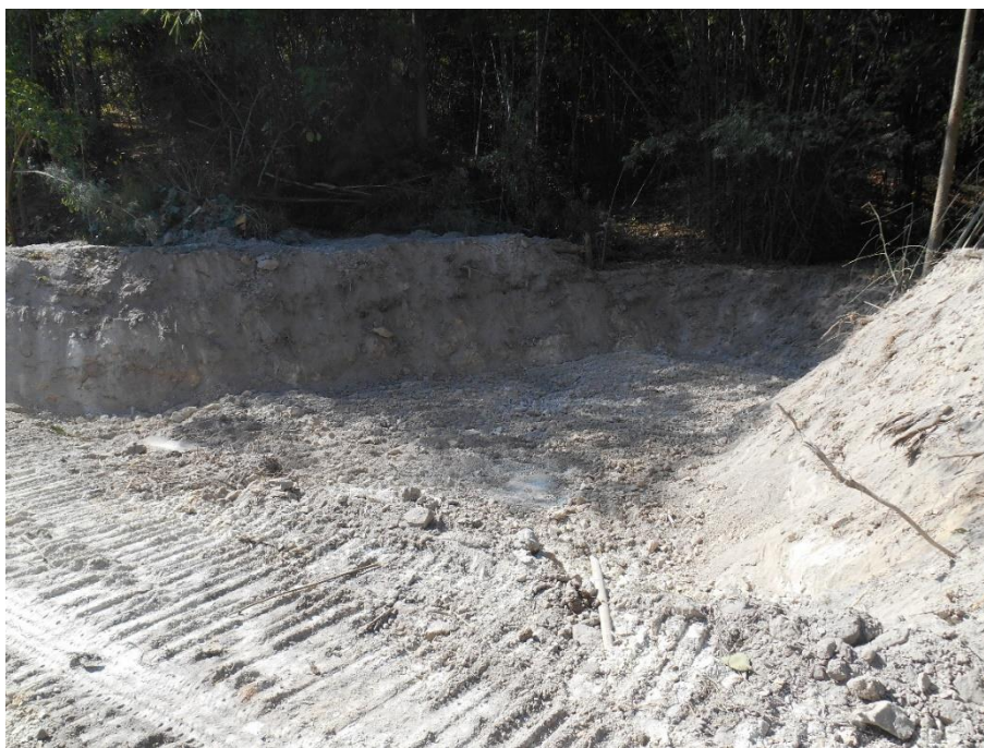
ภาพที่ 4.59 การสร้างบ่อดักตะกอนดิน
