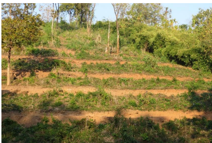
ภาพที่ 4.56 การทำคันดินเพื่อลดการพังทลายของหน้าดิน
